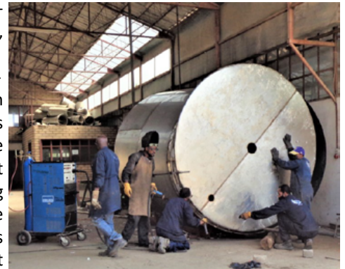
Zusammenbau eines Getreidesilos
